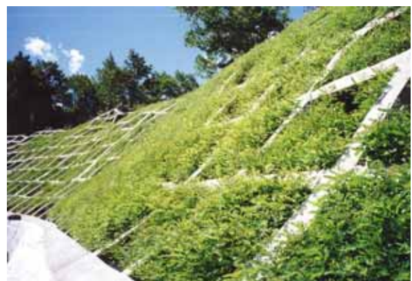
枠内吹付の事例 （吹付枠内に吹付施工）
