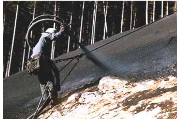
吹付工（痩せ地、硬質土、岩盤など土質によって厚さ3cm～10cmに吹付）
