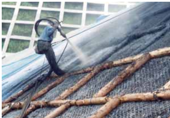
間伐丸太を利用した事例 （丸太のり枠内に吹付施工）
