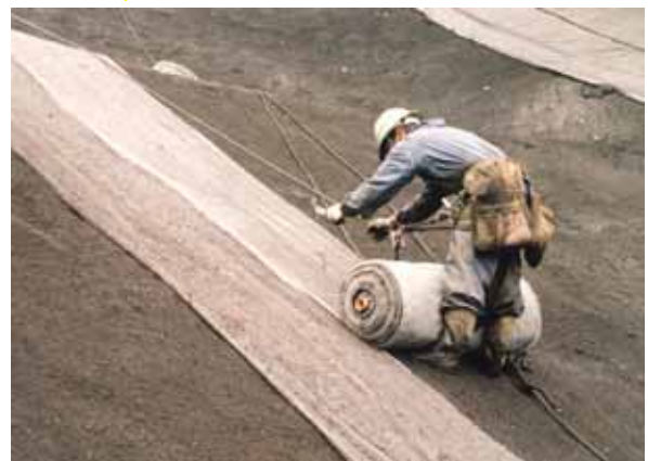
緑化ネット張工 （標準仕様：種子付きの植生ネットの張付け）
