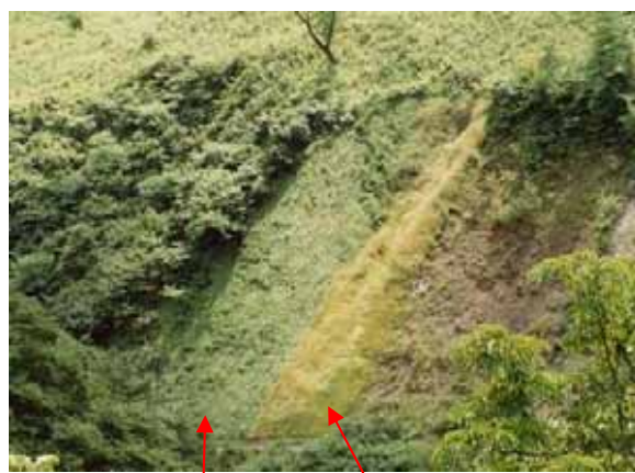
PMC工法 厚層基材吹付工
