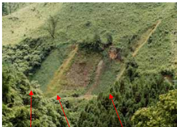
PMC工法 厚層基材吹付工 植生マット工
