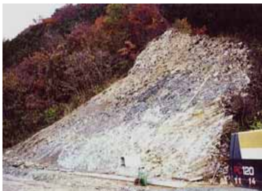
施工前：岩盤切土のり面
