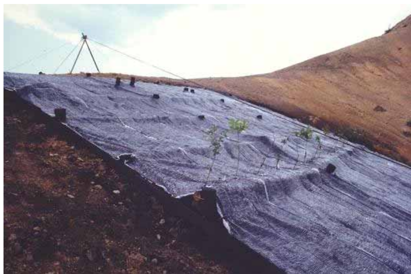
平成3年7月完了（吹付工 + 緑化ネット張工）
