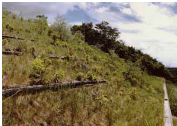
試験地周辺の本施工状況
