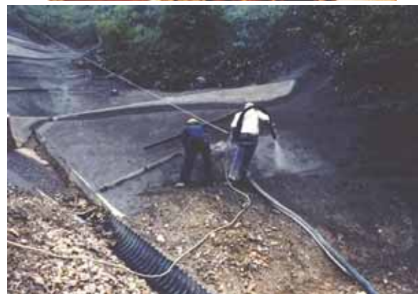
吹付工 t =8 cm (石灰処理吹付 3 cm含む)
