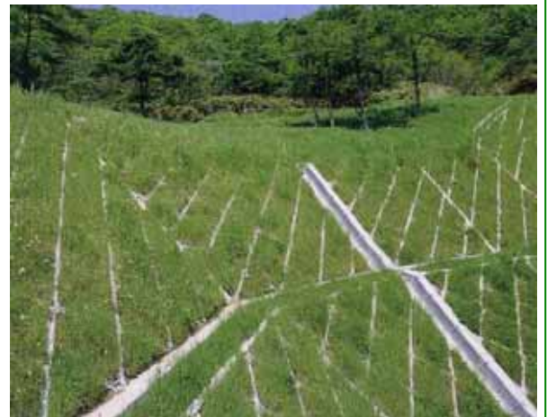
<法枠ブロック+緑化基盤吹付工> 中詰材には、リサイクル緑化基盤材 を吹付ける法面緑化工(PMC工法)
